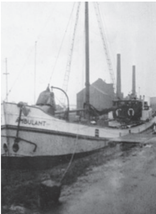
De nieuwbouw AMBULANT (1925) aan hetzelfde steigertje als op de foto twee bladzijden terug, met de suikerfabriek op de achtergrond.
