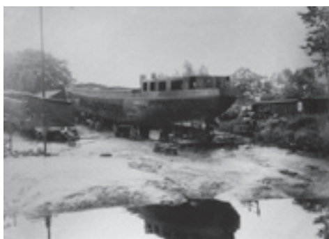
1965. De FRANCINA in aanbouw voor M.C. Leunis in Terneuzen. De afmetingen waren: 57,37x7,26x2,52m – 675 ton met een 460 pk Deutz.
