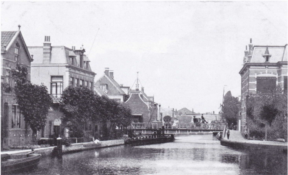
Een prentbriefkaart van circa 1915 met daarop de vroegere draaibrug van Boskoop. In 1936 werd deze vervangen door de huidige hefbrug. Het tweede pand van links bestaat nog steeds en is tegenwoordig een restaurant. De Gouwe was toen nog niet verbreed.
