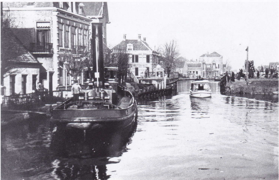
Op 25 november 1935 werd de oude draaibrug voor het laatst gebruikt. Na de doorvaart op deze foto bleef de brug open en begon men met de verbreding van de Gouwe en de bouw van de, nog steeds beeldbepalende, hefbrug. Men moest toen tijdelijk gebruik maken van een (nood)klapbrug. Links ligt een sleepboot van de firma Pannevis.
