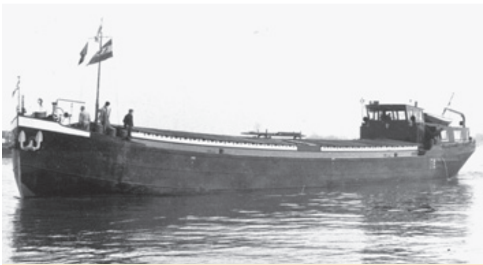
ms MARIE van Theo de Bot uit Made. Type motorschip, ex sleepschip. Bouwjaar 1910 in Gouwsluis bij D. Boot, bouwnummer 413. Afm. 43,70x6,58mx2,12m, groot 388 ton. Eind jaren vijftig omgebouwd tot motorschip in Drimmelen bij de fa. Van Beek. Er kwam een 105pk Kromhout in. Brandmerk 330B Breda 1929.
