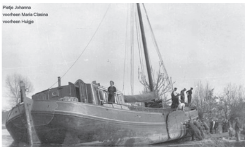
Het klipperaakschip PIETJE JOHANNA van A. de Graaf uit Lage Zwaluwe wordt weer in zijn element geduwd, nadat het eerst met storm bovenop de kade in de haven van Lage Zwaluwe was gekomen. Eig. in 1922. Bouwjaar 1908 in Foxholsterbosch. Afm. 25,43mx5,13mx1,66m, groot 131,077 ton. Brandmerk 876B Gron 1928. Op 5 juli 1948 uitgerust met een zijschroef.
