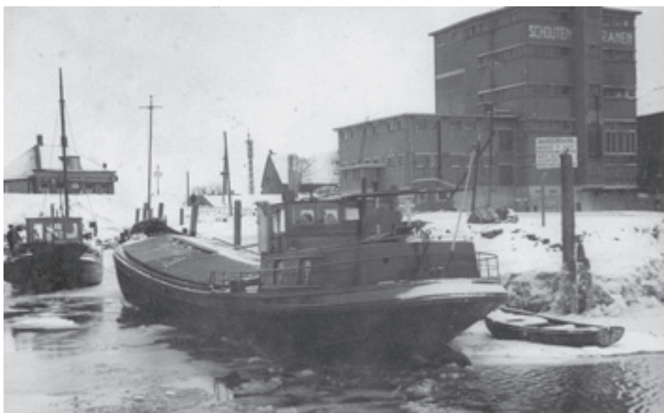
ms Catharina van P. Thijssen uit Made, bij Schouten Granen ergens aan de Lek. Type motorschip. Eig. in 1934. Bouwjaar 1915 in Goudarak bij Duijvendijk. Afm. 26,01mx4,97mx1,63m, groot 123 ton. In 1967 omgebouwd tot pompboot voor cementoverslag: naam Overslag 15. ENI nr. 02300184.
