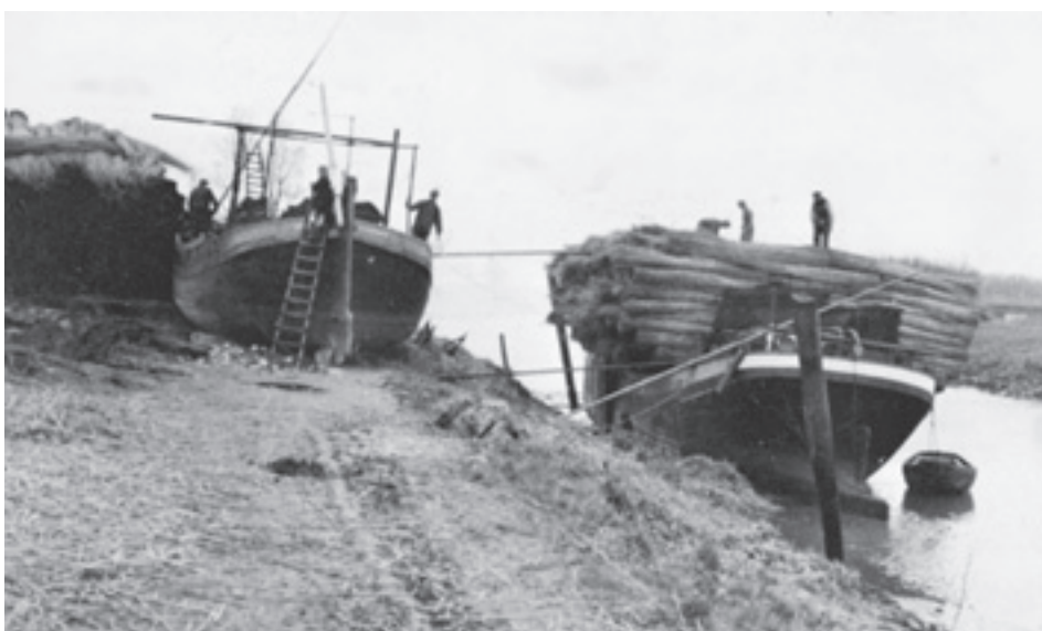
1943 De klipper EBEN HAËZER rechts, 125 ton van W.W. ten Haaf Pzn. uit Zwaluwe, laadt riet over van de stevenaak TWEE GEBROEDERS, 84 ton, van Cornelis Stoop uit Made. Met slecht weer is het schip in de haven van Lage Zwaluwe op de wal terecht gekomen.
