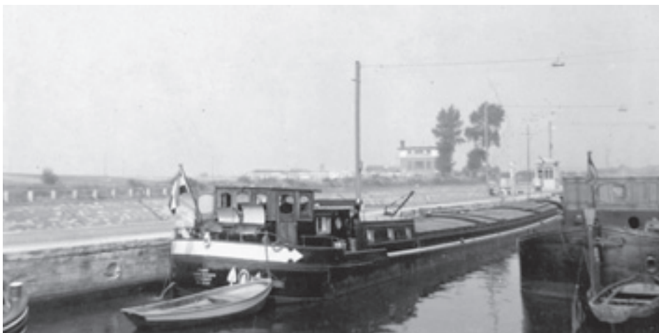
ms CORRY van Adrianus M. Broeders uit Made afvarend in de sluis van Spiere op de Bovenschelde. Type motorspits. Eig. in 1960. Bouwjaar 1939 in Thuin(B) bij Michol Frères. Afn. 39,04mx5,06mx2,30m, groot 344,585 ton. Brandmerk 537B Breda 1955.
