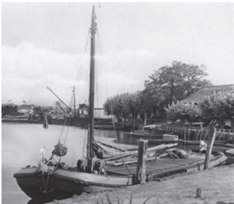
BROEDERTROUW van Huib Roeven uit Made in de haven van Drimmelen 1939. Bouwjaar 1892 in Papendrecht. Afm. 17,37mx4,06mx1,31m, groot 51,544 ton. Brandmerk 129B Breda 1927.
