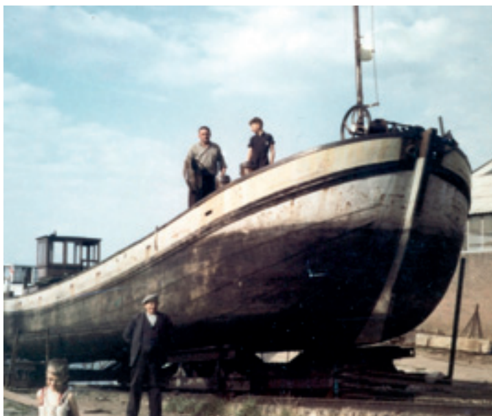
1958 De aak GEERTRUIDA van Huib Brouwers uit Drimmelen, daar op de werf bij Hitters (langshelling). In het schip staat een 30pk Kromhout gloeikop. Aan boord staan Huib met zoon Cees. De man bij het schip is Jan Schuller, de schoonvader van Huib, schipper van de JENATTA. Gebouwd in Drimmelen(?) ca 1902. Groot 52 ton.
