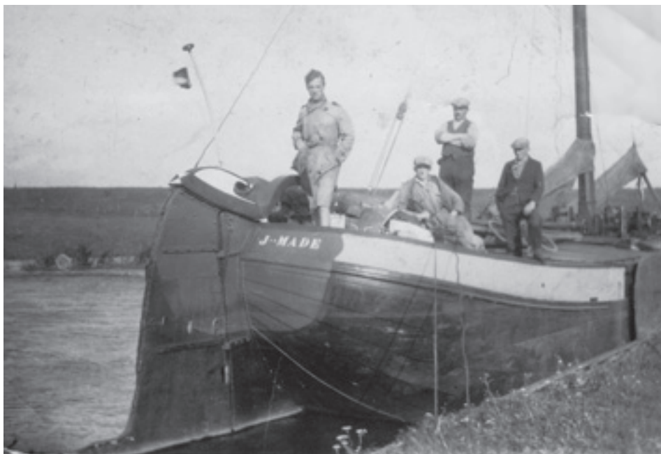
DE VROUW CLAZINA van Joh. van der Made uit Made. Jan staat in het midden met de armen over elkaar. Type boeieraak van ijzer. Bouwjaar 1901 in Drimmelen. Afm. 12,80mx3,60m, groot 23,244 ton.
