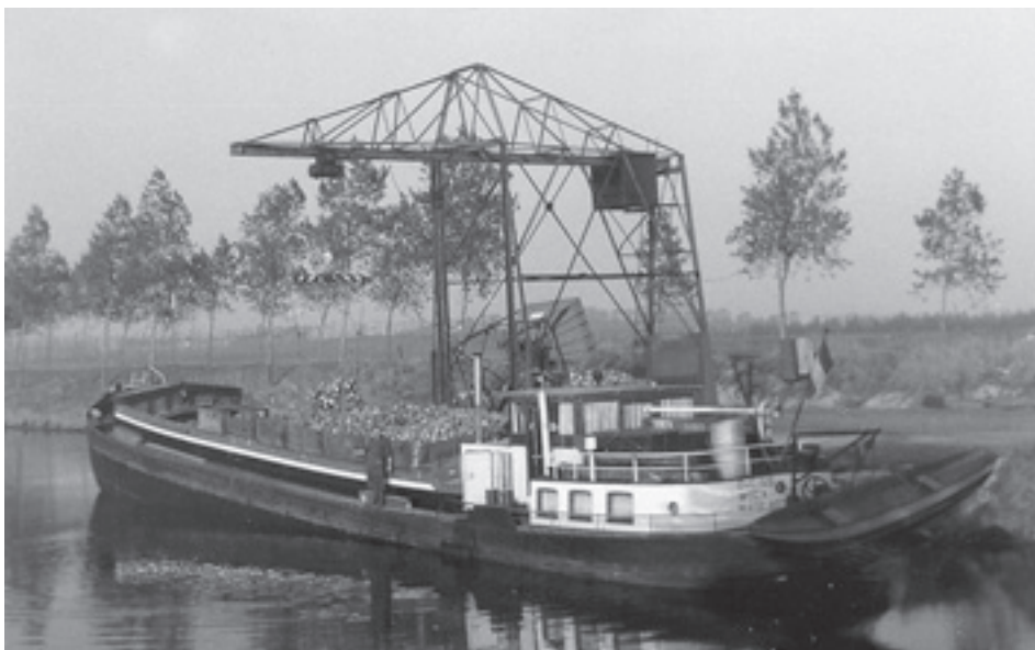
1965 ms Wijca van Cor van Gils uit Made. Bieten laden in Nieuwland. Zoon Wijnand staat in het gangboord. Type motorschip, 120 pk Modag. Bouwjaar 1925 in Stadskanaal bij O. Smith. Afm. 26,58mx5,04m, groot 126,998 ton. Verlengd in september 1950 naar 34,60mx5,06mx1,99m, groot 210,034 ton. Brandmerk 932B Rott 1927.
