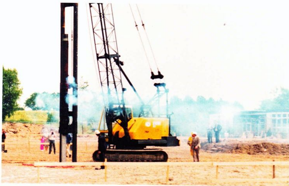
Het nieuwe gebouw komt even ten noorden van de dependances te staan. Bij het heien van de eerste paal zien we rechts nog net dependance I.
