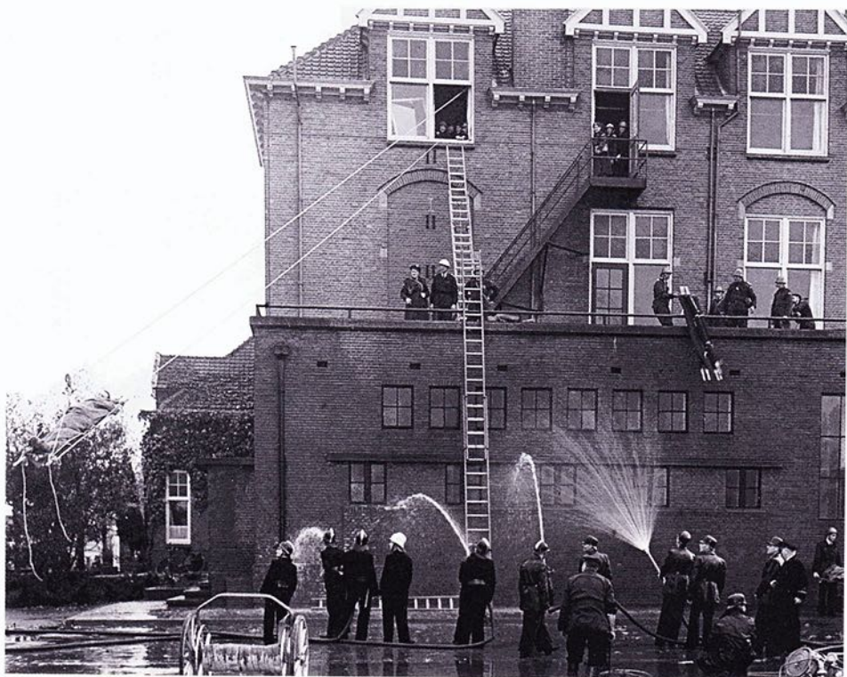
Op deze foto oefent de vrijwillige brandweer. Bekend is dat zij met blinddoeken om het gebouw in moesten om bij rookontwikkeling toch de weg te kunnen vinden.
