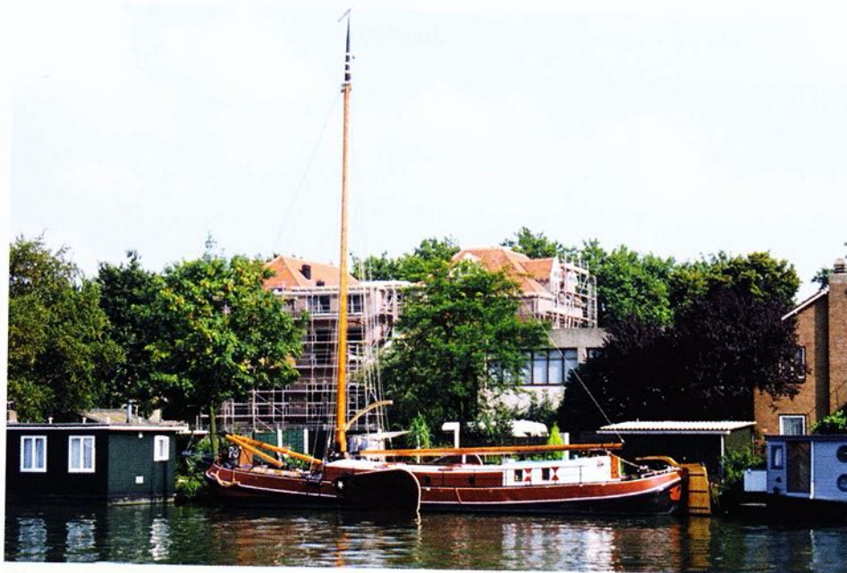
Na een periode van verval en vernielingen wordt het oude internaatgebouw verbouwd en ingericht als appartementencomplex. De opening daarvan vond plaats op 2 maart 1994.
