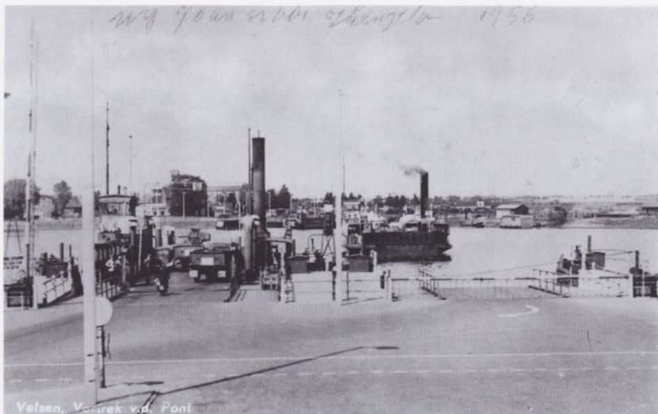
Al sinds de opening van het Noordzeekanaal in 1876, varen er ponten over deze toegangsweg van de haven van Amsterdam naar de zee. Rijkswaterstaat nam de veerdienst over het Noordzeekanaal voor zijn rekening. Op de foto zien we de stoomponten op de veerdienst Velsen-IJmuiden.
