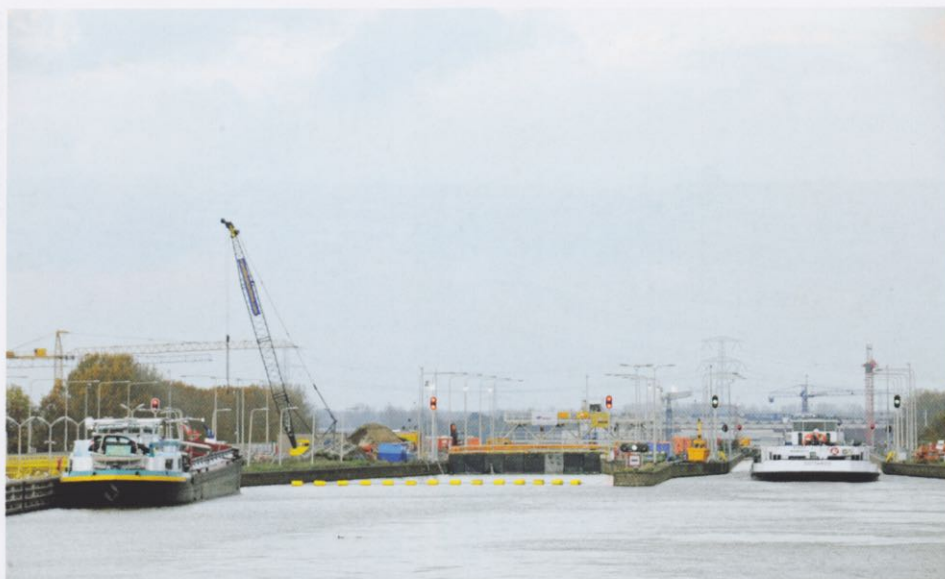
De oostelijke kolk van de Drielingsluis wordt verlengd tot 225 meter. Om grotere en langere schepen toegang te kunnen blijven bieden op het kanaal, is het nodig om de sluis daarvoor toegankelijk te maken. De vaarweg wordt geschikt gemaakt voor schepen met een lengte van 190 m, een breedte van 11,4 m en een diepgang van 3,5 m. In 2013 is de regiocentrale Zuid in Maasbracht klaar. Vanaf dat moment worden 9 sluizencomplexen op het traject Maastricht-Belfeld op afstand, via camera's, aangestuurd.
