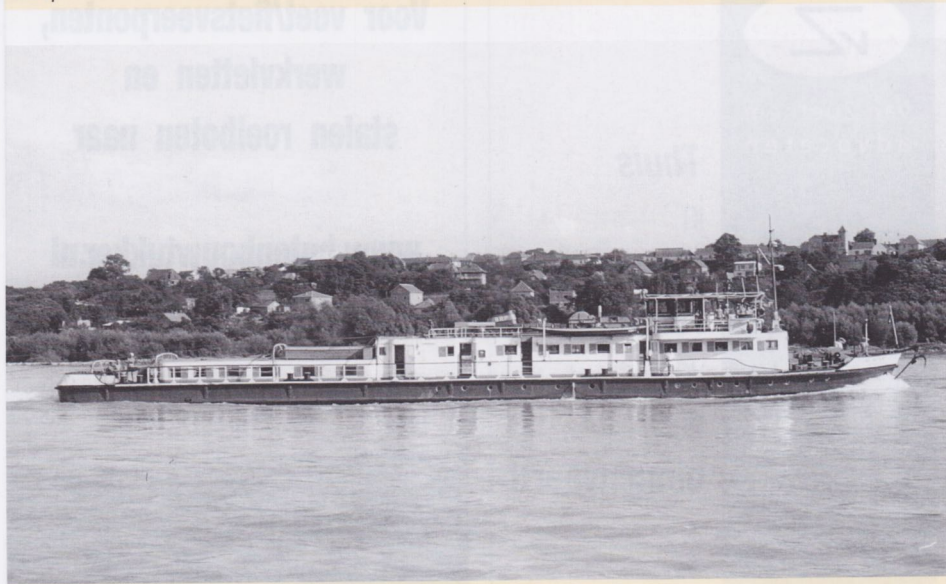
De CHRISTO BOTEV was met haar 2140 paardenkrachten de sterkste sleepboot van de Bulgaarse BRP. De boot werd in 1958 in Beograd gebouwd, was 50,50 m lang en 8,00 m breed. Het trekvermogen was over twee motoren verdeeld. Op de benedenloop van de Donau nam de boot met gemak 10 sleepschepen mee.
