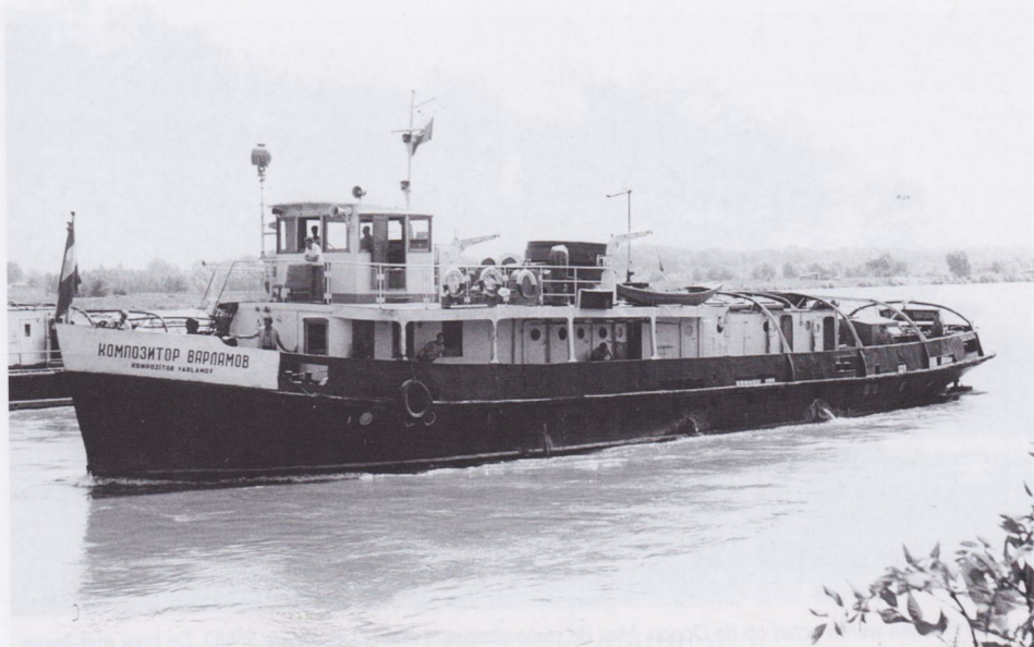
De Sovjet-motorsleper KOMPOSITOR WARLAMOV van de SDGP was 40,26 m lang en 7,82 m breed. Er stonden twee motoren van 323 pk in. Het bouwjaar en de bouwwerf zijn onbekend.
