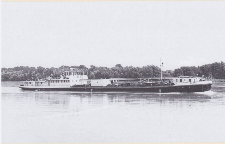
Het Sovjet-tankschip SIVASCH kon ook slepen. Het was in 1940 in Turnu Severin (Roemenië) gebouwd als S.T.A.D. I en kwam door de oorlog vanaf 1945 in Sovjethanden. Gegevens: 73,10 x 9,01 m; 1105 ton; 2 x 500 pk. Op de foto is het schip in de zomer van 1962 te zien op de Donau bij Wenen.
