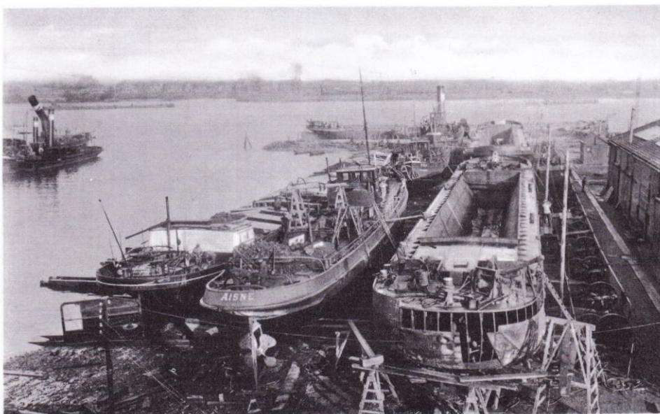
Deze foto uit het archief van Jaap Boersema toont ons de bedrijvigheid op de werf 'De Biesbosch' in vroeger tijden. We zien hier onder andere de sleepboot AISNE, een onderlosser en een sleepschip op de 'electrische' dwarshelling. Daarachter liggen nog diverse schepen op de helling.
