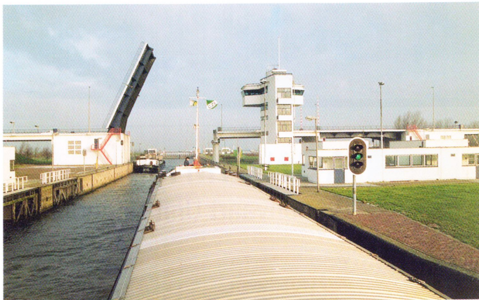
Vanaf 28 juli 1975 zijn de Houtribsluizen voor de binnenvaart in gebruik. De beide kolken zijn elk 190 meter lang en 18 meter breed. Behalve het spui- en schutbedrijf is ook de Centrale Meldpost IJsselmeergebied in het bedieningsgebouw van de Houtribsluizen gehuisvest.
