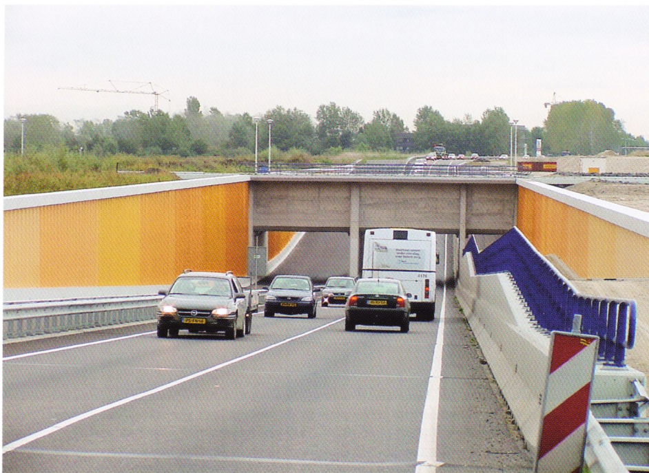
Op 29 januari 2003 opende minister De Boer van Verkeer en Waterstaat de nieuwe oeververbinding tussen Flevoland en Gelderland: het 'Aquaduct Veluwemeer'. Het aquaduct vervangt de oude Hardersluis. De doorvaart bestaat uit een brug van zeven meter hoog en een aquaduct voor de vaartuigen met staande mast.
