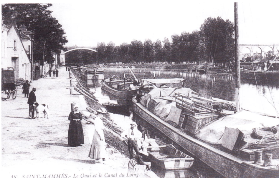
18 SAINT-MAMMÉS.- Le Quai et le Canal du Loing.
