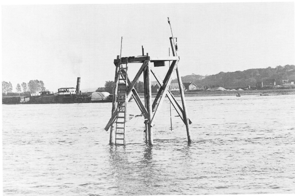
Een foto uit 1933. De eerste pijler, van een nog af te bouwen steiger van 100 meter, waaraan scheepjes met materiaal kwamen te liggen voor de nog te bouwen Nijmeegse brug. In opvaart gaat een afgeladen goederenboot van de Badische Aktiën Ges. Mannheim. Later van het Fendel concern.
