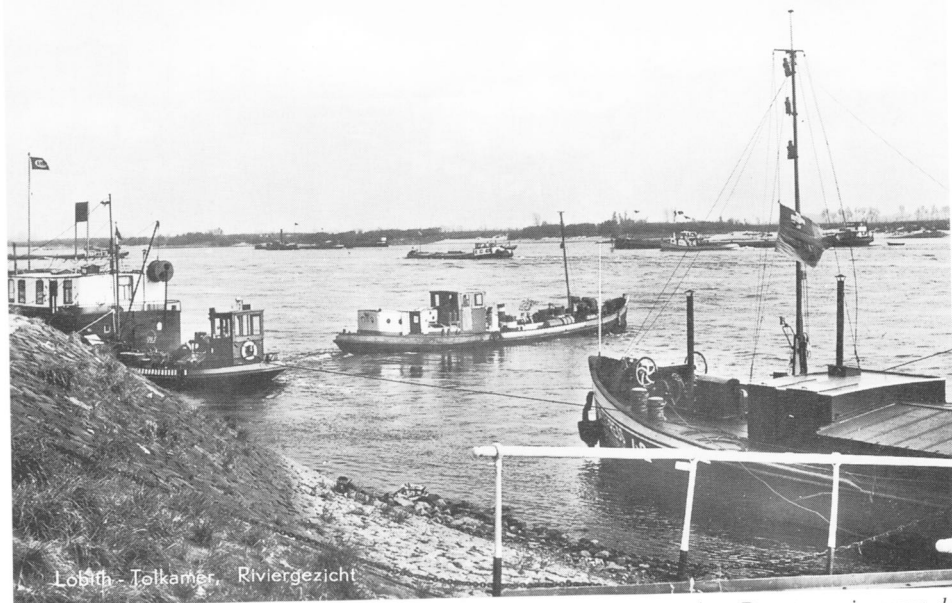
Voor de wal de EXPRESS 42. Op het bunkerstation wappert de Essovlag. Daartussenin -voor de wal- een bunkerbootje van Gulf (1962).
