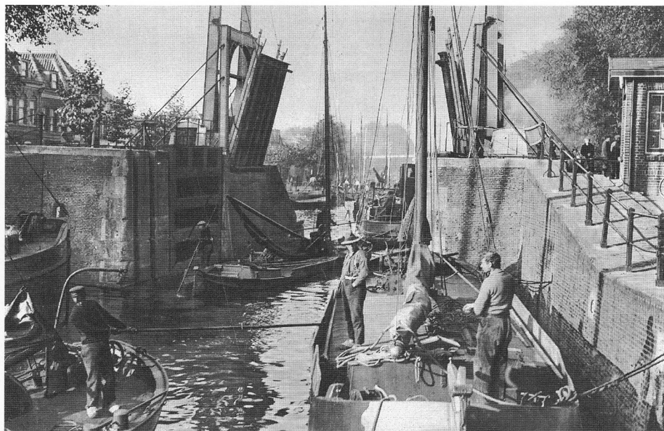
1927. Invaart via de bovenkolk van de Oude Sluis, die bij extreem hoog water op de Lek gebruikt moest worden. Rechts het kantoortje van de sluismeester. Het motorschip achter het bruggenhoofd laat de motor nog even flink draaien en onder de brug boomt en duwt een beugelaar (zandschipper) zijn aakje naar binnen. Over bb. zaten een mastenmakerij, de schippersbeurs, Van Loon-sleepvaart (annex café), het tagrijn van Monster en (nu nog steeds) café De Hoop.
