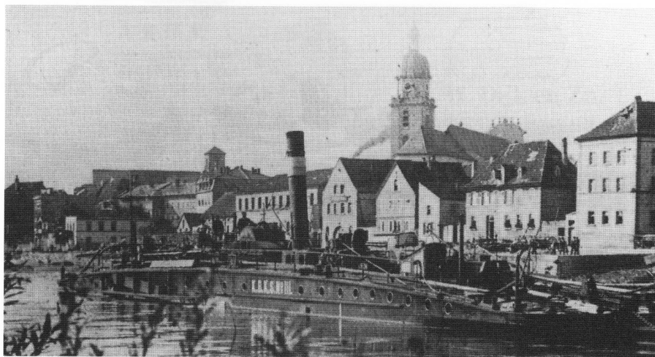
Kettingsleepvaart op de Main. De kettingsleper 'K.B.K.S. nr III' van de Königliche Bayerischen Kettenschlepp Schiffahrt bij Kitzingen a/d Main. Zij werd in 1898 gebouwd in Übigau a/d Elbe, lxb: 50 x 7,40 m / 130 pk. In 1924 herdoopt in D.R.G. KS III van de Deutschen Reichsbahn Gesellschaft Kettenschleppschiffahrt.
