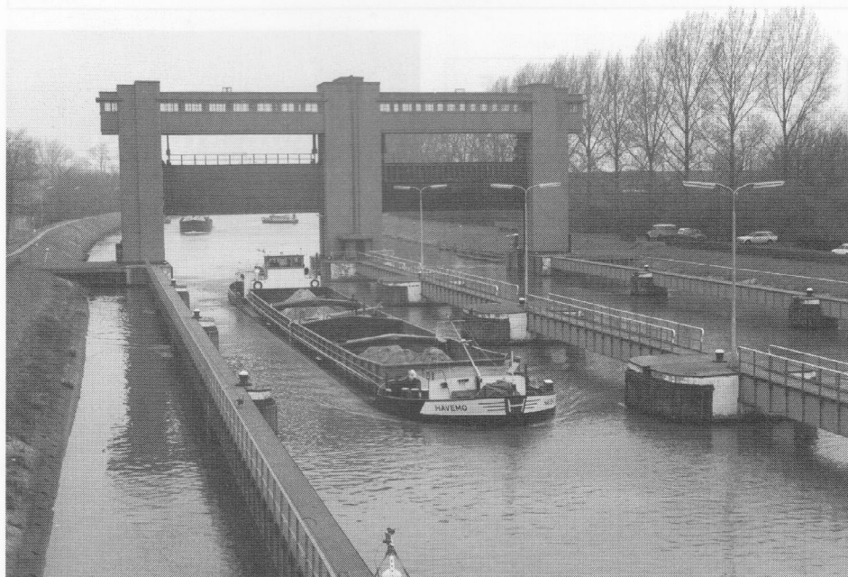
De laatste sluis van het Julianakanaal te Limmel. Binnen Rijkswaterstaat spreekt men bij dit type sluizen over een 'groene' kolk. De sluis staat meestal open; bij Maasstanden boven NAP+44,00 m wordt gesloten, bij standen hoger dan NAP+45,30 m is de sluis gestremd.
