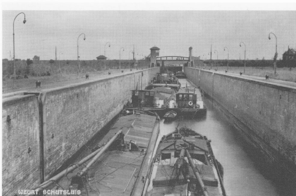
Er is weinig hoogteverschil binnen en buiten de sluis van Weurt. De benedendeur is al een klein eindje open. Zo dadelijk kunnen de grindmannen uitvaren en hun losplaatsen zien te bereiken.
