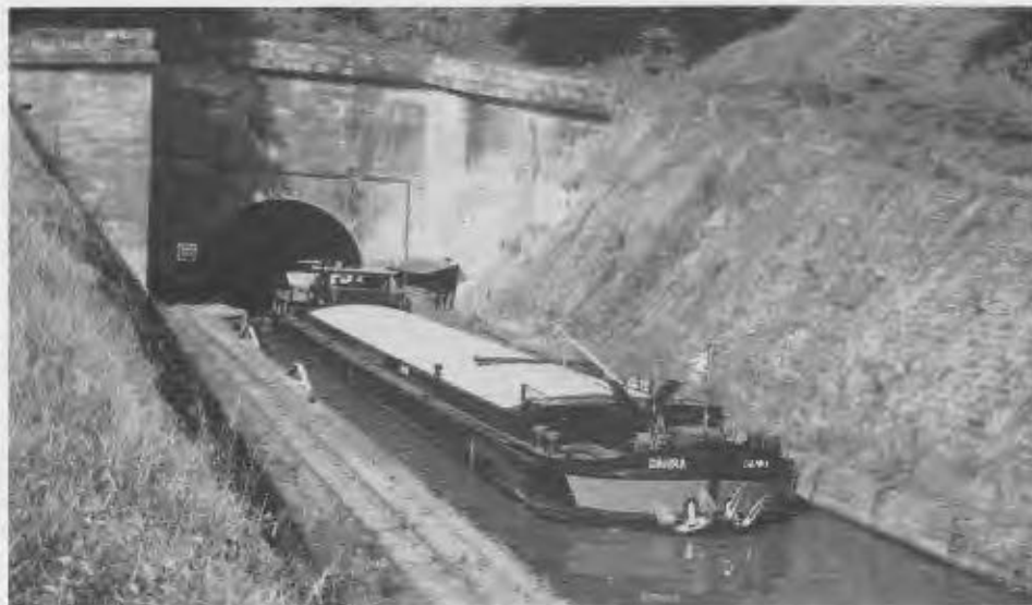
mv's DAHRA verlaat aan de oostzijde de souterrain van Arzviller (2306 m) gelegen in het Canal Marne au Rhin. Aan de westzijde van souterrain Arzviller liggen de ingangen van de spoor- en scheepvaarttunnel naast elkaar, maar de spoortunnel daalt langzaam, hetgeen de scheepvaarttunnel niet kan (zonder sluizen) en kruist zich onder de scheepvaarttunnel door. Tijdens de Tweede Wereldoorlog is het dak van de spoortunnel opgeblazen, waardoor het kanaalpand droog viel. Foto: Hans Schuitemaker
