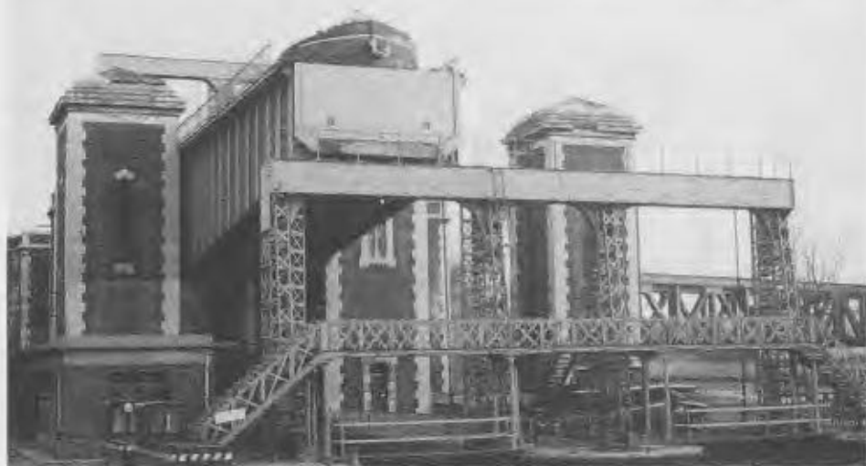
ARQUES. Ascenseur des Fontinettes is een hydraulische balancelift met een hoogteverschil van 13 m. Het totaalgewicht van de bak is 800 ton. Als energiebron voor het openen en sluiten van de deuren wordt waterkracht gebruikt. In 1991 was een bezoek aan dit museum zeer interessant, in beide troggen lag een spits. In de onderste spits is een expositieruimte gevestigd met een filmvertoning van een der laatste scheepspassages door de lift. Foto: archief Hans Schuitemaker
