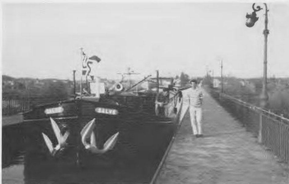
De SALVÉ in de Pont Canal Briare. Gustaf Eifel (de bouwer van de Eiffeltoren) was in de vorige eeuw de grootste ingenieur van ijzeren constructies. Onder zijn mede-verantwoordelijkheid is dit 664 m lange aquaduct door de constructeurs Dayd & Pille op 15 pijlers over de Loire gebouwd. In 1894 was het voltooid en in 1896 is het geopend voor de scheepvaart. Foto: Ben Boode
