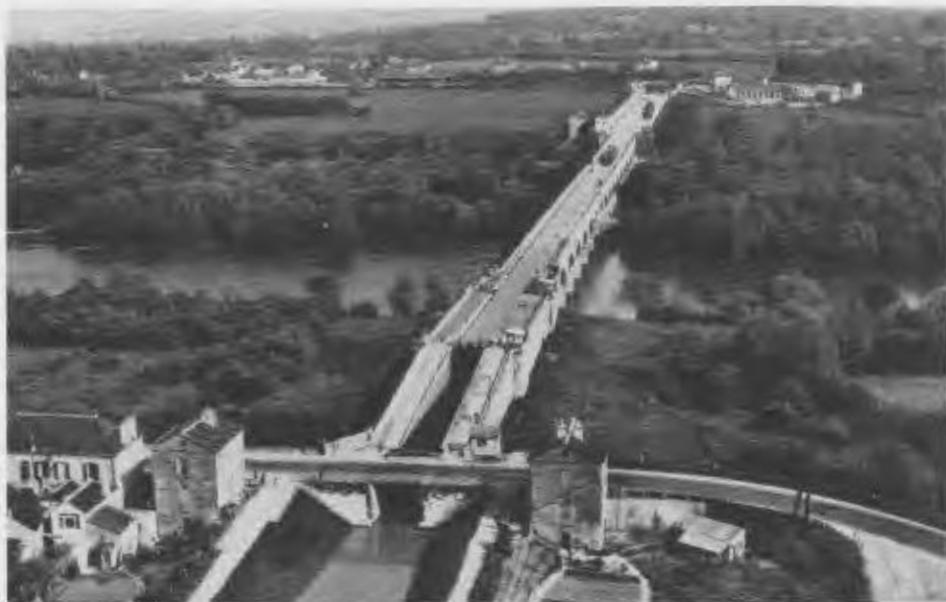
PONT CANAL GUÉTIN. Dit, in 1835 gebouwde, aquaduct is 450 m lang en leidt het Canal latéral à la Loire over de Allier en heeft een dubbele sluis met een verval van 9,50 m. Foto: archief Egbert de Jonge
