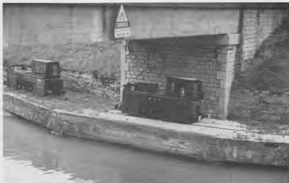
Twee "tractions" (inmiddels buiten gebruik gestelde elektrische locomotieven) onder de brug van Mauvage, \pm 1 km van de souterrain van Houdelaincourt. Foto: Hans Schuitemaker
