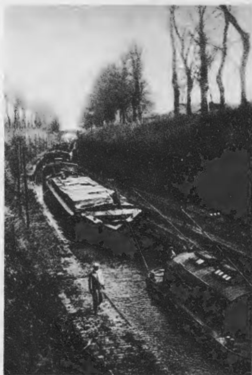
De kettingboot van Pouilly en Auxois de TOUEUR (lxb: 15 x 3,20 m). De originele motor was een omgepoolde dynamo van 550 volt, 19 kW bij 900 toeren. Op 18-09-1987 maakte schipper Mr. Remond er de laatste reis mee. Foto: Hans Schuitemaker
