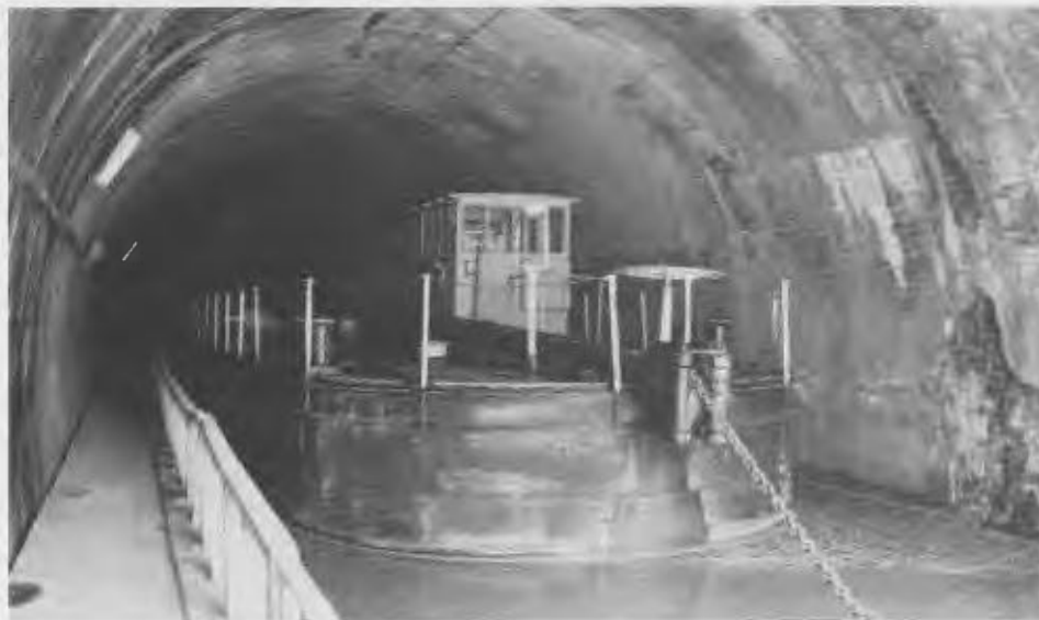
Souterrain Houdelaincourt (4878 m) is gelegen in het Canal Marne au Rhin tussen Toul en de Marne. Wegens onvoldoende ventilatie wordt de beroepsvaart door middel van een kettingboot (in de volksmond "RAM"), door de tunnel getrokken. De pleziervaart mag meestal, na betaling, op eigen kracht doorvaren. Foto: Hans Schuitemaker
