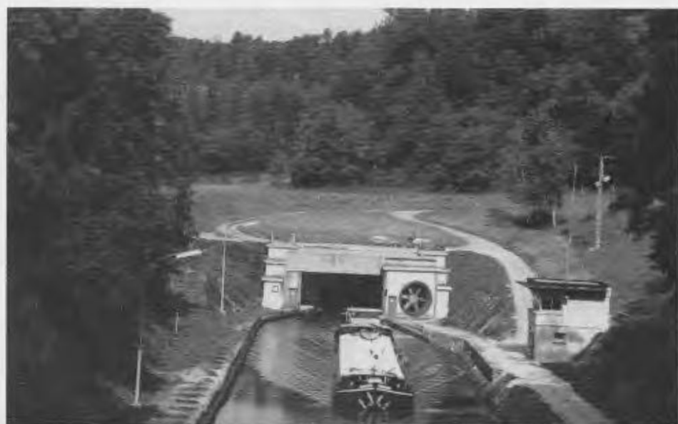
Op de foto, rechts van de spits, is duidelijk een grote luchtventilator te zien. Deze maakt het mogelijk dat de schepen op eigen kracht door de tunnel kunnen varen. De zuidzijde van de souterrain van Braye (2300 m) in het Canal de l' Oise a l' Aisne (in de volksmond Canal de Abbécourt). Foto: Hans Schuitemaker
