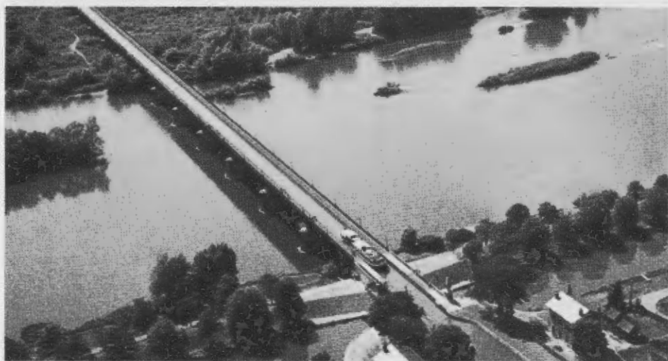
PONT CANAL BRIARE. De Loire is met haar 1052 km de langste Franse rivier, maar is onbevaarbaar m.u.v. de 150 km vanaf de kust. In de vorige eeuw is tussen Briare en Digoin het 196 km lange Canal latéral à la Loire aangelegd. Het heeft 37 sluizen en 3 grote aquaducten te Briare, Guetin en Digoin. Het verbindt samen met het Canal du Centre, Canal de Briare en Canal du Loing, de Saône met de Seine en heeft een verbinding met het Canal du Nivernais. Foto: archief Hans Schuitemaker
