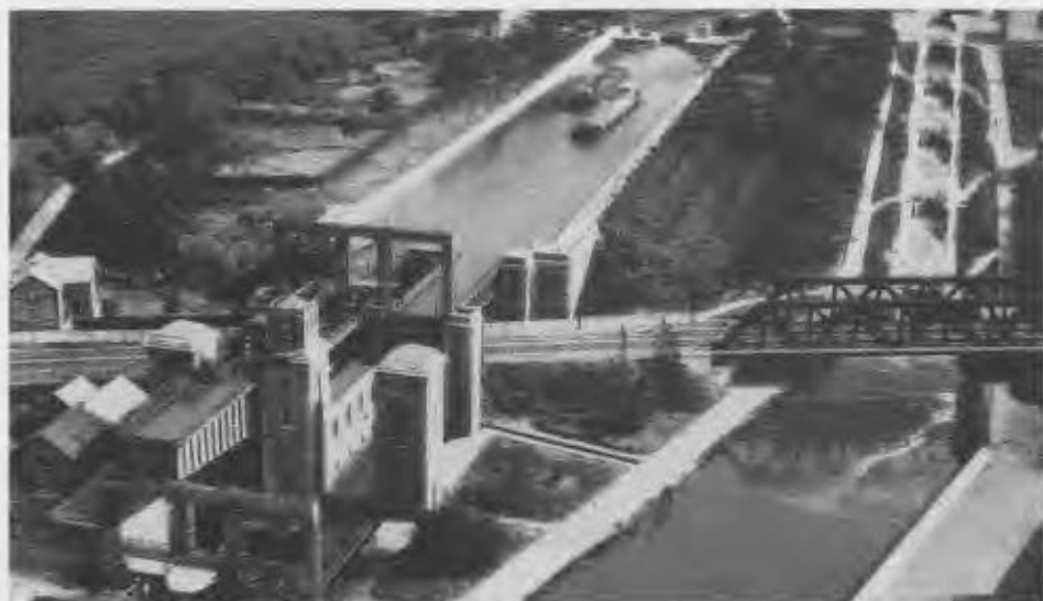
ARQUES LES FONTINETTES. Deze scheepslift en een vijfsluizentrap is gelegen bij St. Omer in het Canal de Neuffossé. De lift is van 1888 tot 1967 voor de scheepvaart in gebruik geweest en na de bouw van de nieuwe sluis (op de plaats van de sluizentrap) buiten werking gesteld. Foto: archief Egbert de Jonge
