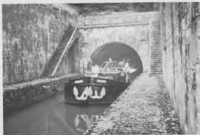
Tunnel te St. Albin op de Saône.
